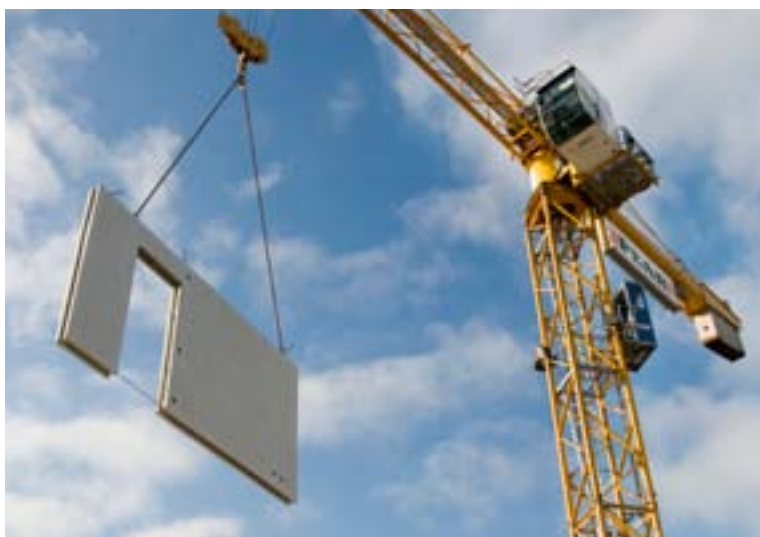
Skandinaviska Byggelement (SBE) har levererat skalväggar, plattbärlager och balkonger till Fjärilsparken – en grönskande miljö mitt i Vellinge utanför Malmö. Brf Fjärilsparken består av totalt 32 bostadsrätter och inflyttning beräknas påbörjas under maj 2011. På bilden syns en skalvägg med fönsterhåll som lyfts på plats.
