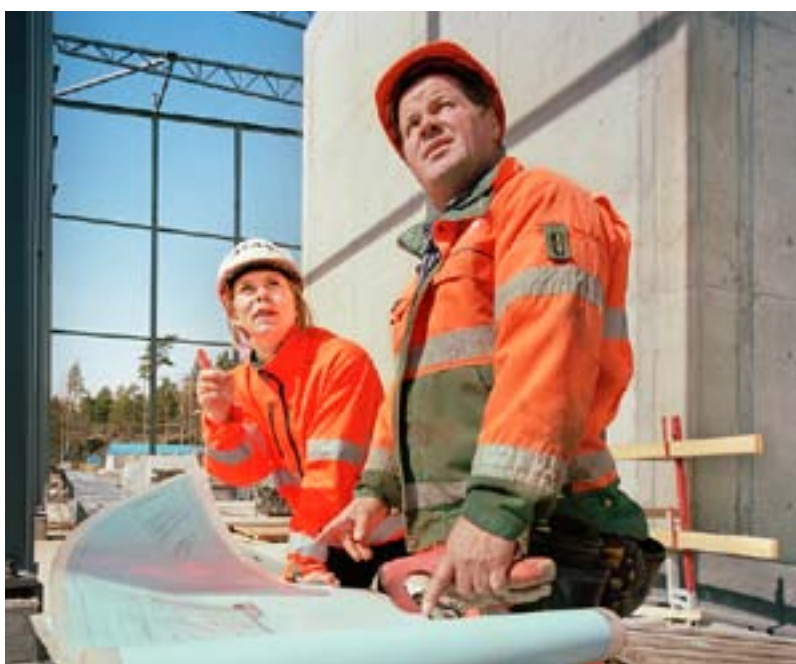
När Vattenfall AB 2009-2010 uppförde en biobränsleeldad anläggning vid Jordbro Värmeverk var Peabs uppdrag att utföra markarbeten, grundläggning och betongarbeten för ett nytt pannhus även innefattande bränslelager och tippfickor. Arbetet var en totalentreprenad.
