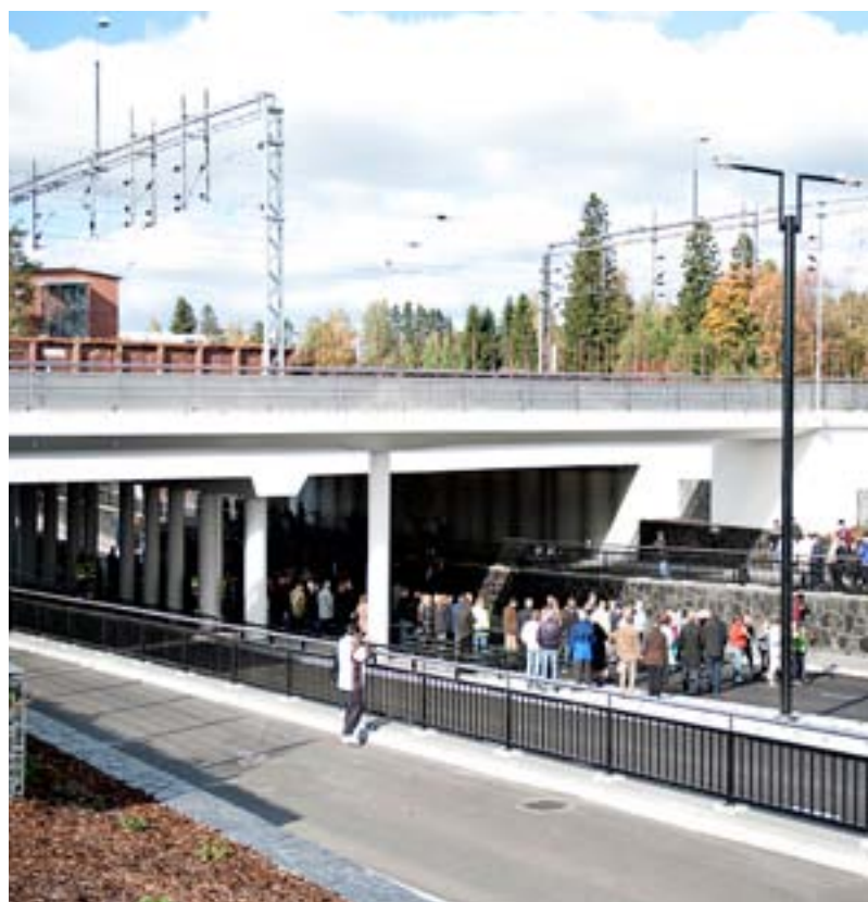
Under hösten 2010 invigdes fem järnvägsbroar i Vanda utanför Helsingfors i Finland. Beställare var Banverket och Vanda stad och arbetet omfattade även markarbetet.
