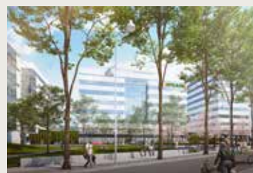
I Ulriksdal utvecklar Peab en helt ny stadsdel med helhetslösningar inom hållbar stadsutveckling. Här utvecklas attraktiva och levande stadsmiljöer med såväl bostäder som kommersiella fastigheter. Peabs nya kontor etableras i området, den BREEAM-certifierade fastigheten, på cirka 12 000 kvm, kommer att stå klar för inflyttning för cirka 500 av Peabs medarbetare under 2019.
