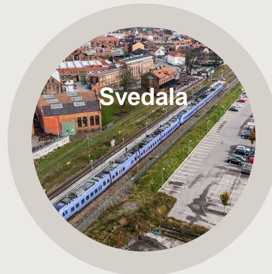
Upprustning av tågstation (106 Mkr)
