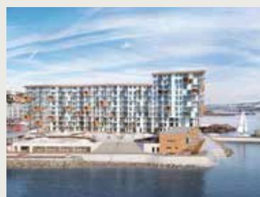
I samma område som Himmel & Hav i Tromsø, bygger Peab projektet Skir, kommersiella lokaler samt 180 ägarlägenheter. Uppförandet sker i två faser och de 80 första ägarlägenheterna ska vara inflyttningsklara under första kvartalet 2021. Hela projektet skall vara färdigställt fjärde kvartalet 2021.
