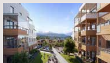
I Tromsø har Peab utvecklat projektet Norheim med totalt 122 bostäder. Miljöaspekten är en viktig parameter i projektet, som ska miljömärkas med Svanen. Byggstart var under 2020 och hela projektet ska stå klart 2023.
