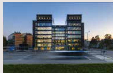
Ultimes Business Garden II i Helsingfors är en kontorsbyggnad på sju våningar med en uthyrningsbar kontorsyta på cirka 7 900 kvm samt 150 parkeringsplatser. Fastigheten färdigställdes och förvärvades av Annhem Fastigheter under 2020.
